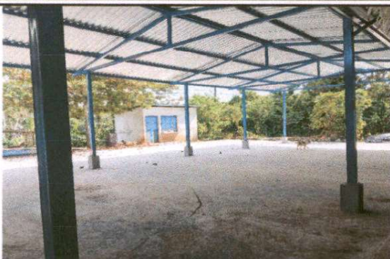
Foto 1: Sustrución de lamina, por lámina troquelada aluzinc calibre 26, módulo de patio
