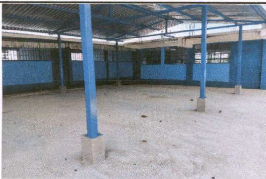
Foto 3: sustitución de suelo, por piso de concreto, módulo de patio
