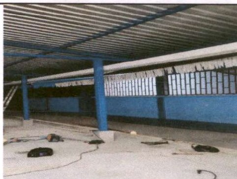
Foto 4: sustitucion de canal PVC, módulo de patio
