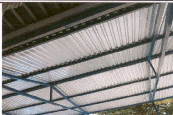
Foto 2: sustitucion de estructura de soporte de madera, por metal, módulo de patio
